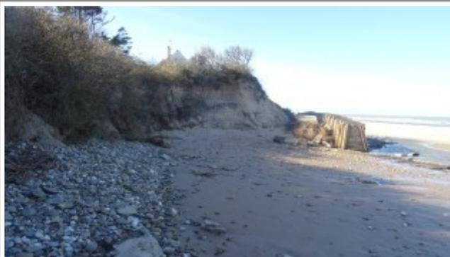
Effondrement de la dalle et mur en parpaing. La dalle est maintenant sur l'estran.
